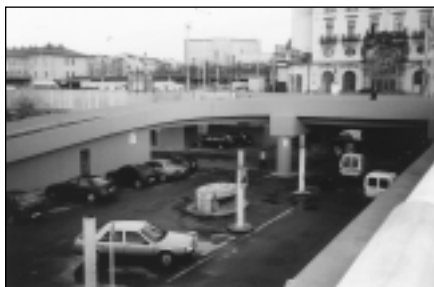
Obr. 2: Opravená část ramp
