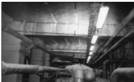
Obr. 2: Podhled stropu se zateplením
