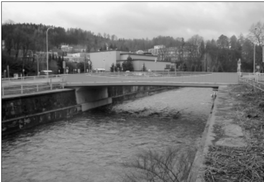
Obr. 1: Podélný pohled na mostní objekt
