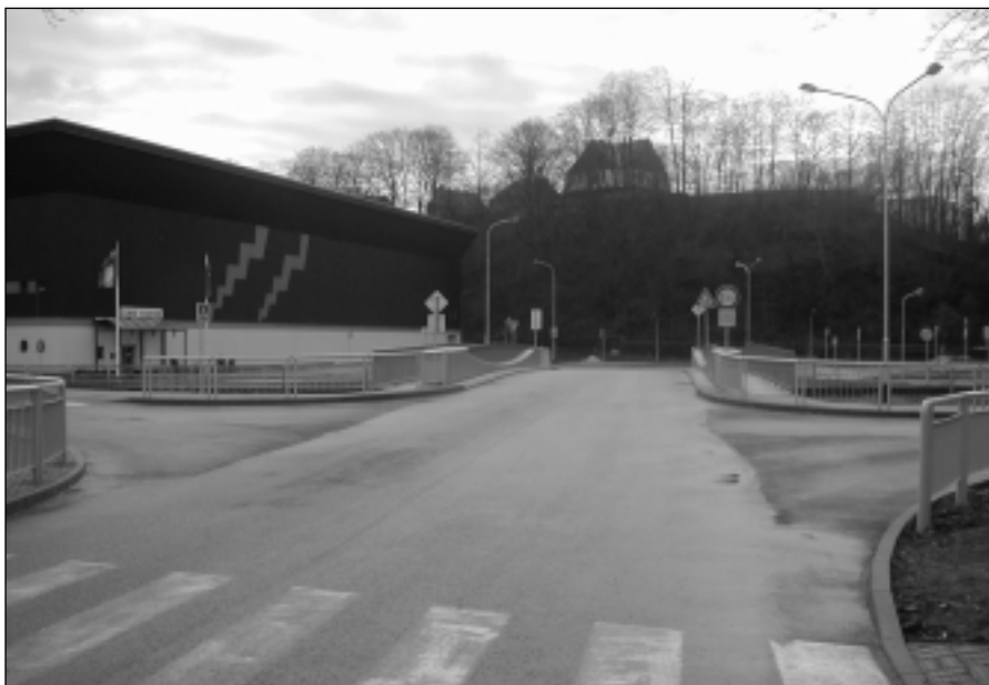
Obr. 2: Pohled na předpjaté parapetní nosníky proměnné výšky
