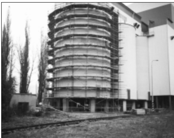
Pohled na sila před demontáží lešení
