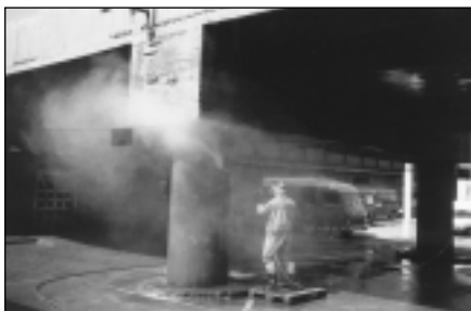
Obr. 1: Tryskání VVP spodní stavby
