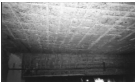
Obr. 1: Podhled stropu se zasanovanou výztuží
