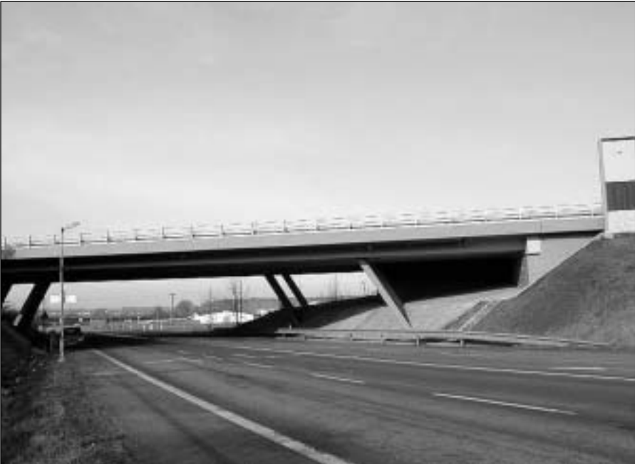
Obr. 2: Most po opravě
