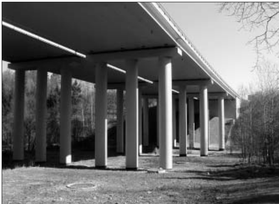
Obr. 2: Pohled mostu po opravě
