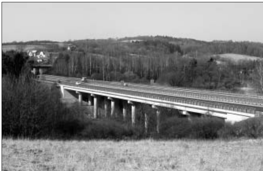
Obr. 3: Pohled na hotový most
